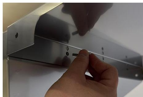
Die Schrauben mit dem Montagewinkel im Inneren des Grillkopfes verschrauben, **noch nicht anziehen!**
